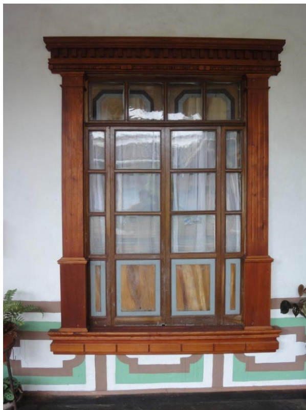
Foto No. 11: Detalle de Ventanas y puerta ventanas
