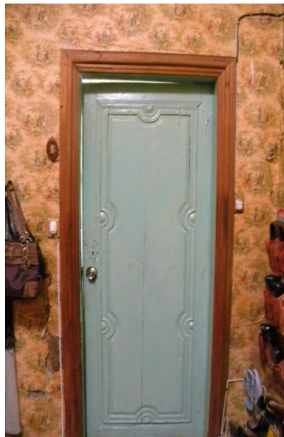
Imagen No. 3: Casa Familia Eguiguren Valdivieso, 1700s
