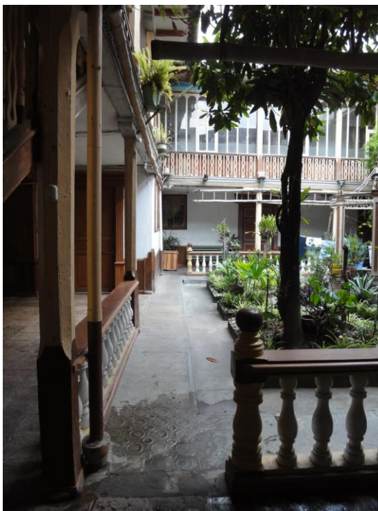
Foto No. 16: Corredor y patio lado norte planta baja
