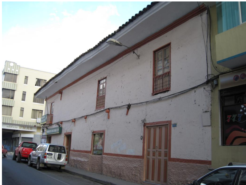
Foto No. 33: Vista de la calle Colón con la construcción nueva
