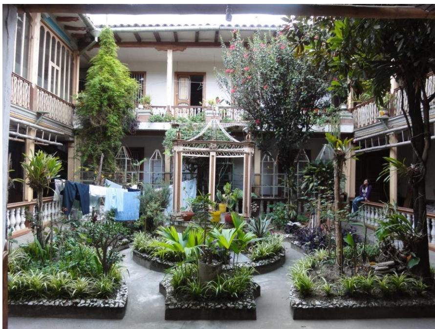
Foto No.20: Patio central planta baja
