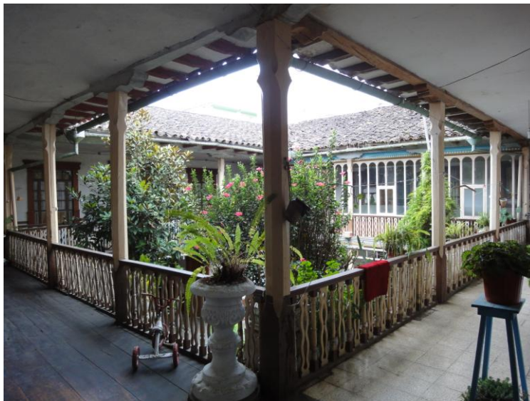
Foto No.7: Panorámica de la planta alta esquina noroccidental
