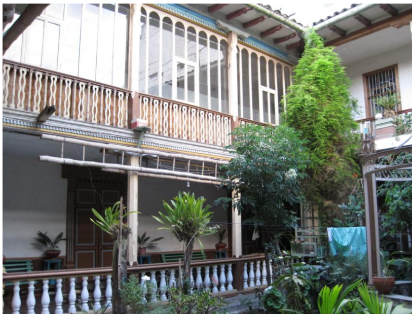
Foto No.22: Detalle de pasamanos superiores e inferiores
