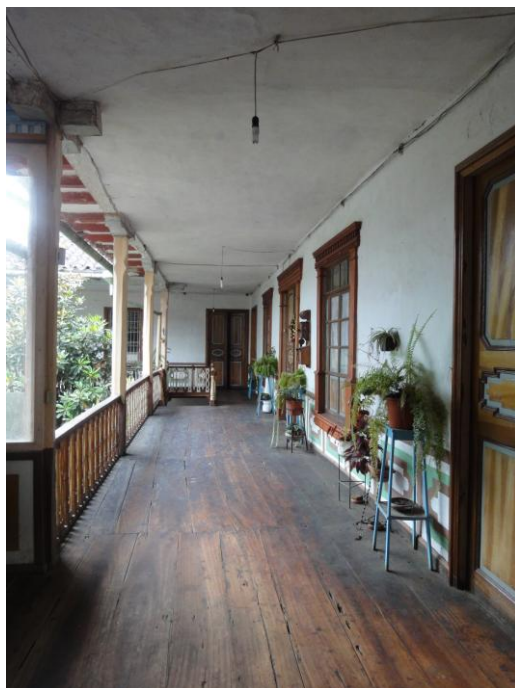
Foto No. 13: Vista del corredor sur planta alta
