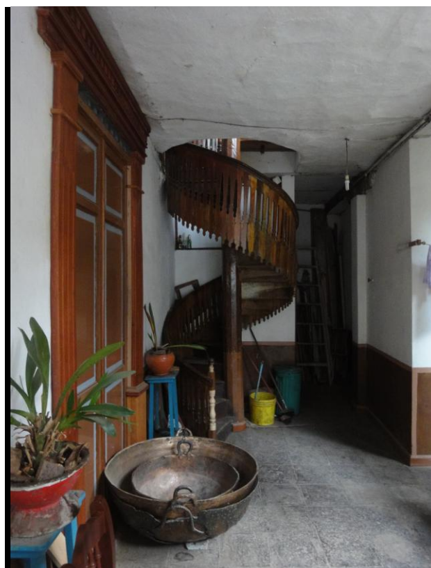
Foto No. 21: Vista del detalle de la grada de servicio Planta baja
