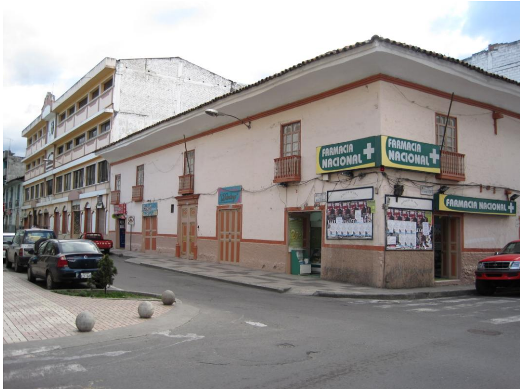
Foto No. 32: Esquina de la calle Bolívar y Colón
