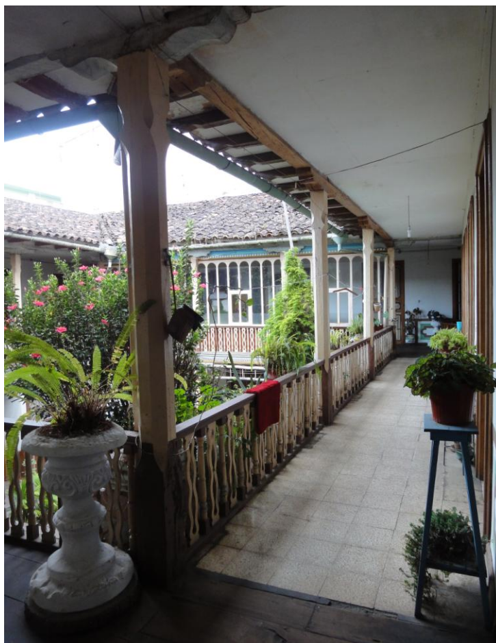
Foto No. 8: Vista del corredor occidental planta alta
