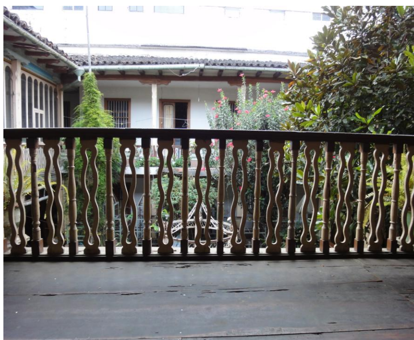
Foto No. 10: Detalle de pisos y pasamanos planta alta
