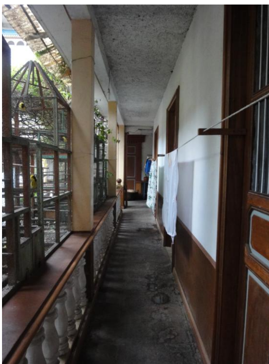
Foto No. 17: Corredor lado occidental planta baja
