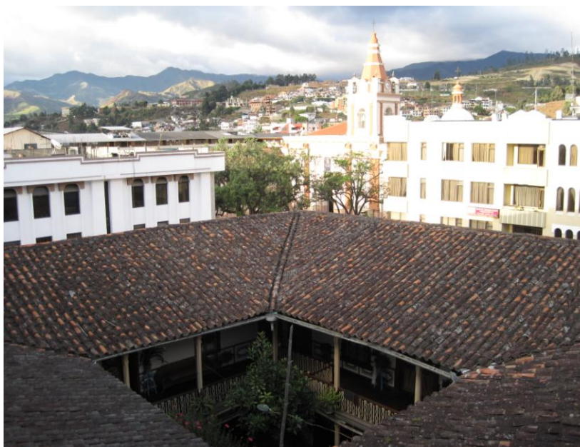
Foto No. 23: Vista superior la cubierta
