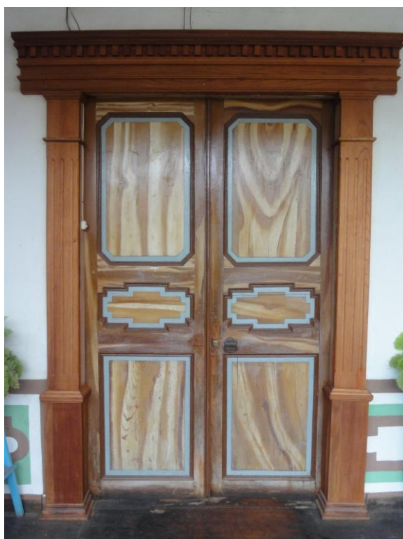
Foto No. 12: Detalle de puertas
