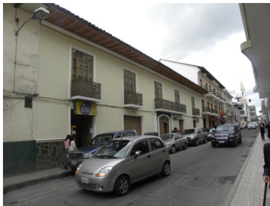
Imagen No.8 Colegio Cordillera, de 1800s:
