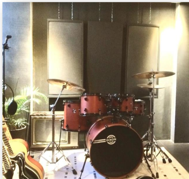
Figura 3. Paneles de absorción acústica en una sala de ensayo
